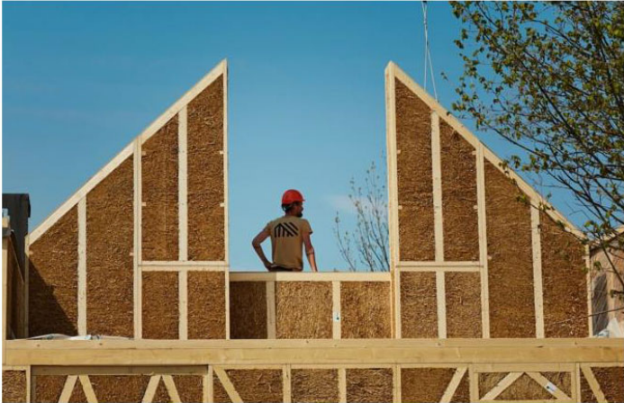
Billede: JDH-byg fra Aarhus er begyndt at bygge huse isoleret med halm.
